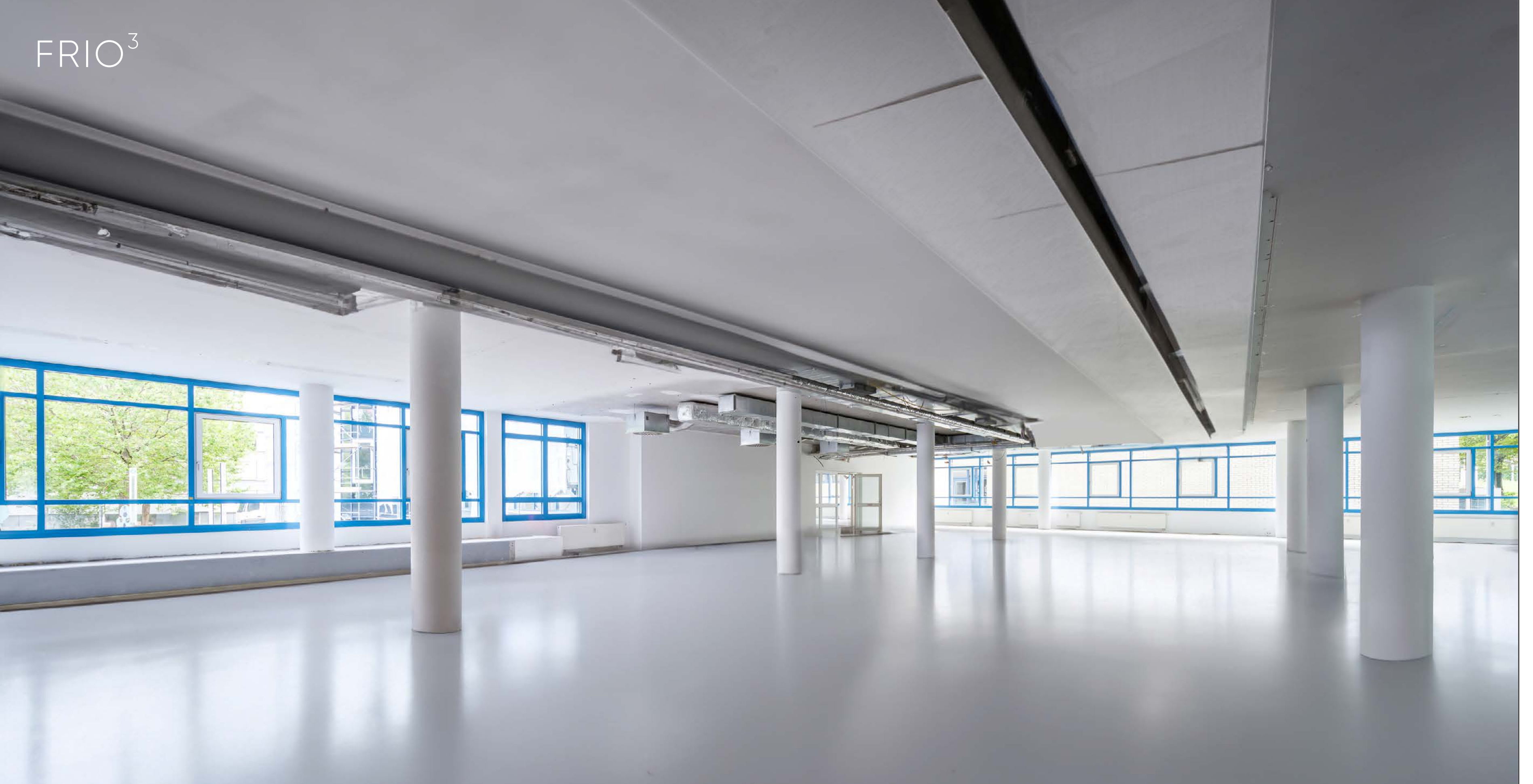
Erdgeschoss Fläche 2, aktuelle Ansicht
